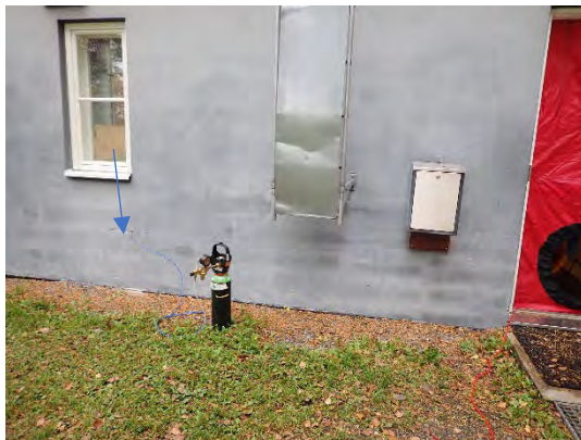
Kuva 1. Merkkiaine laskettiin ulkokautta ulkoseinän eristekerrokseen.
