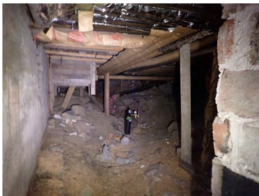
Kuva 3. Merkkiaine laskettiin alapohjan ryömintätilaan.
