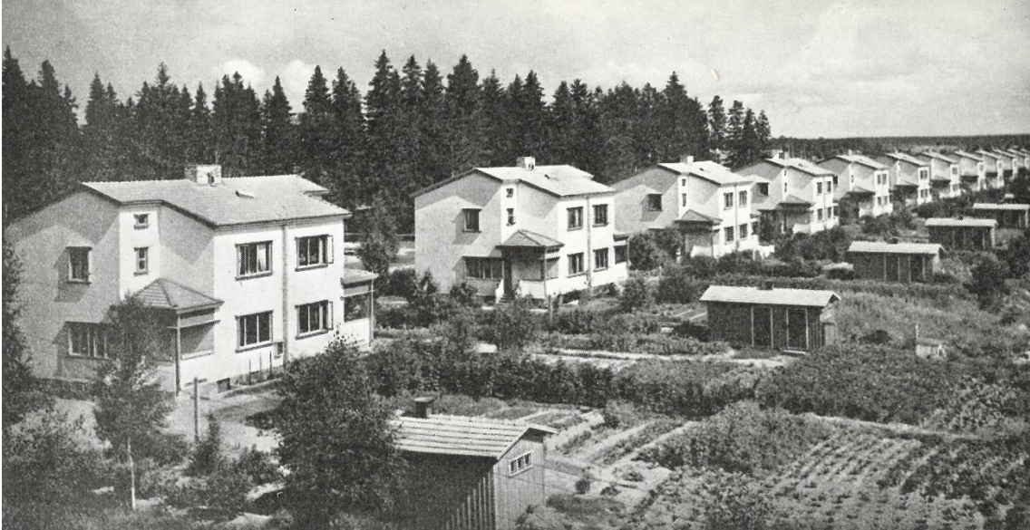
Kuva 2. Friitalan Nahka Oy:n asuinalue 1950-luvun alussa. Alkuperäiset talousrakennukset olivat pieniä satulakattoisia varistorakennuksia, jotka oli katettu tiilikatteella ja verhottu nurkkalaudattomalla peiterimaverhouksella. Alueen pihakasvillisuus on ollut jo tuolloin varsin rehevää. (Kuva: Kopioitu lähteestä Raevuori 1952, kuvaaja tuntematon.)
