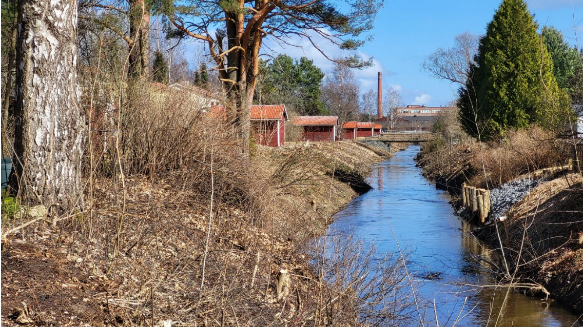
Kuvat 6 ja 7. Suunnittelualueelle avautuu Oikaisuojan suuntaisesti näkymiä mm. aluetta koillisessa rajaa- valta Peltotieltä (ylh.) sekä Oikaisuojan alueen keskivaiheilla ylittävältä sillalta. Oikaisuojan suuntaisesti koil- liseen katsottaessa näkymä kohdistuu suoraan Friitalan nahkatehtaan vuonna 1939 valmistuneeseen van- hempaan laitosrakennukseen (alh.). (Kuva 6: Mikko Toivanen 2025; Kuva 7: Juha Virola 2024.)
