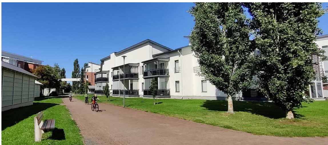
Kuva 4.15. Keskustan uudempaa mutta matalaa kerrostalorakennuskantaa.
