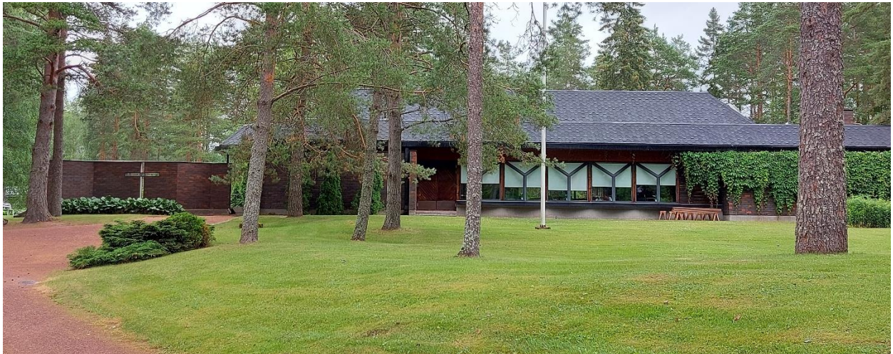
Rauman Lapin seurakuntakoti osana kirkon ympäristöä on laadukas esimerkki maakunnan modernista rakennusperinnöstä. Kuva: Niina Uusi-Seppä
