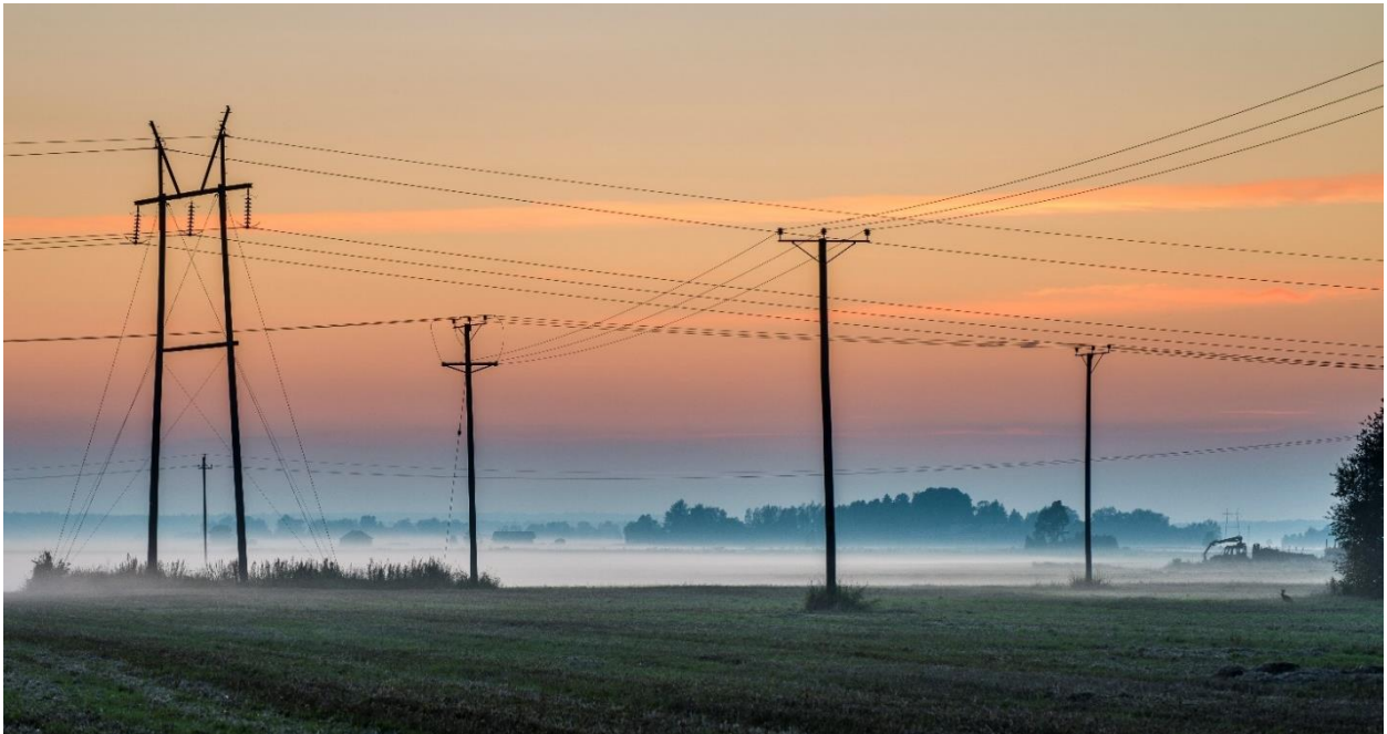
Iltarusko Ulvilan Vainiolan sähköverkkojen ja peltojen yllä. Kuva: Visa Vehmanen
